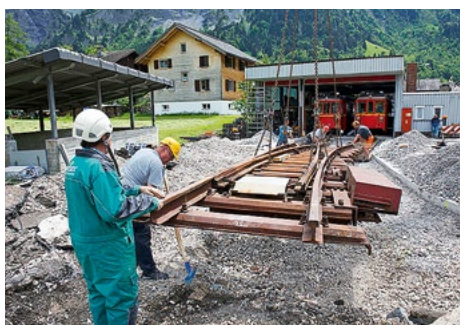
Einbau der ersten Weiche vor dem Depot im Sommer 2020. © Comet Photoshopping GmbH, Dieter Enz
